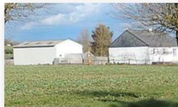
Bardage blanc et contraste de teintes entre toitures et façades, parpaings non enduits Source : Architecte - Conseil de l'Etat / DDT 72
