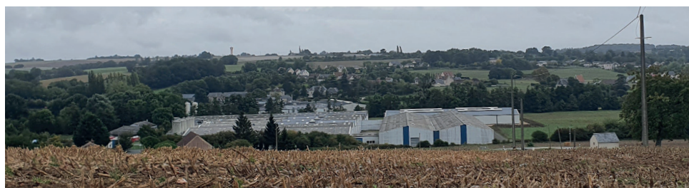
Vue sur l'usine Somater à Marolles-lès-Saint-Calais
